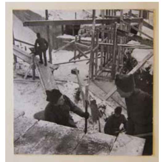
Schalungsarbeiten für die massiven Tankmauern. Stadtarchiv Zürich, Nachlass Stirnemann
