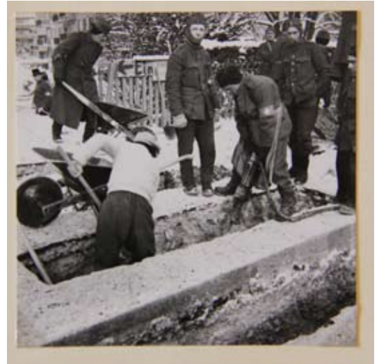
Aushubarbeiten für die Schächte der Steckbarrikaden. Stadtarchiv Zürich, Nachlass Stirnemann
