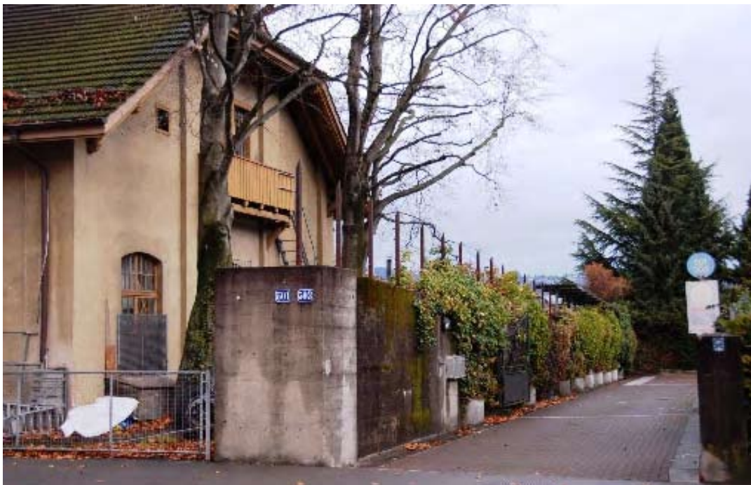
Das östliche Ende der Wollishofer Sperre: Die Tankmauer Z1 zwischen Seestrasse und Seeufer. (Quelle: Zürcher Bunkerwanderführer)
